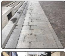
Pavimentazione del percorso in pietra e dell'area in cubetti di porfido con sconnessioni, deformazioni e rotture.
