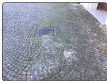
Pavimentazione con sconnessioni, deformazioni e rotture e chiusini non a raso.
