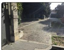
Pavimentazione con sconnessioni, deformazioni, rotture.
