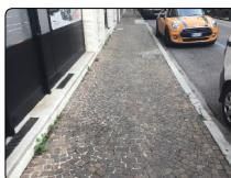
Pavimentazione con sconnesioni e deformazioni.
