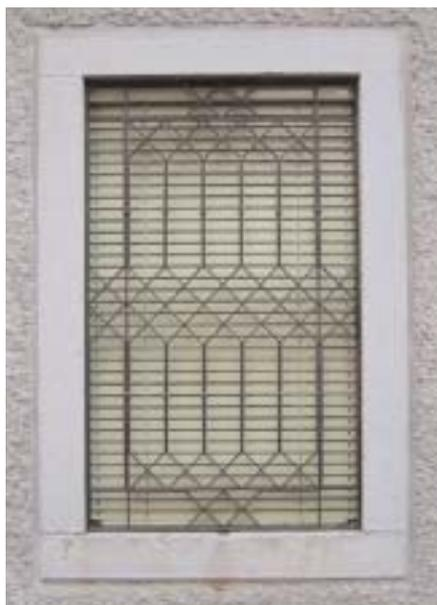
Materiale: profili di ferro generalmente assemblati, con fascette e chiodature e non con saldature.
