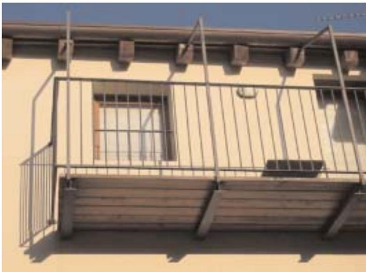
Materiale: la struttura portante e il parapetto sono realizzati con profili metallici, mentre il pavimento è in tavole di legno.
