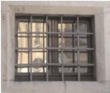
Materiale: profili di ferro prodotti e assemblati meccanicamente.
