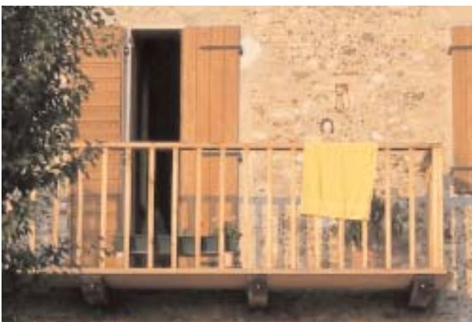
Varianti rispetto al disegno base dei poggioli-ballatoi sono date dall'essere agganciate alla copertura da montanti in legno e dagli elementi di parapetto in doghe verticali od orizzontali. Le tavole in legno del pavimento sono solo accostate (e non incastrate), per evitare il ristagno dell'acqua ed il conseguente infradiciamento del legno.
