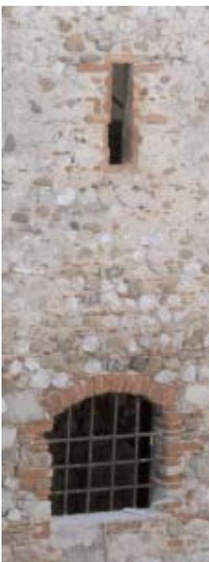
Si ritiene che i caratteri ambientali della zona, che lo strumento urbanistico intende conservare, suggeriscano di limitare i disegni di assemblaggio delle sbarre e le forme di ancoraggio alle murature a quelli tradizionalmente usati.
