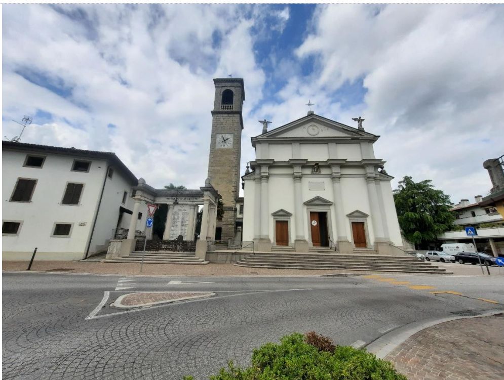
3. La Chiesa di San'Andrea Apostolo a Paderno (da sud verso nord).
