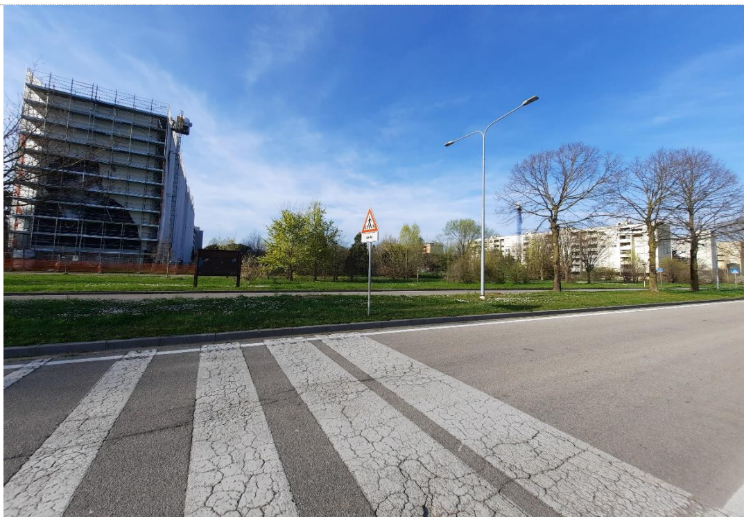
1. Il complesso di palazzine che occupa l'area dove agli inizi del Novecento fu messa in luce la necropoli a incinerazione (da sud verso nord).
