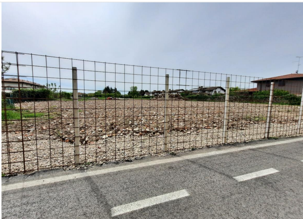
1. Il cantiere dove è stata demolita agli inizi del 2024 la Villa Facchini in Via San Pietro.
