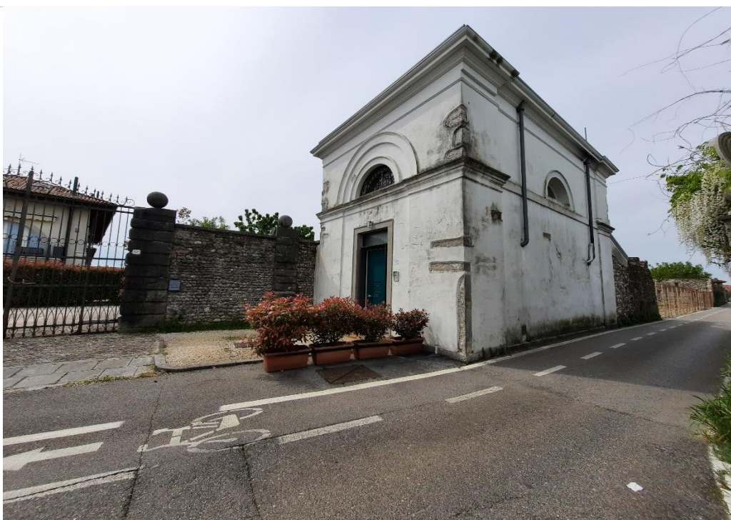
2. La chiesa di San Pietro costruita nel XIX dopo la demolizione della più antica chiesa del XIII secolo (da nord-ovest verso sud-est).
