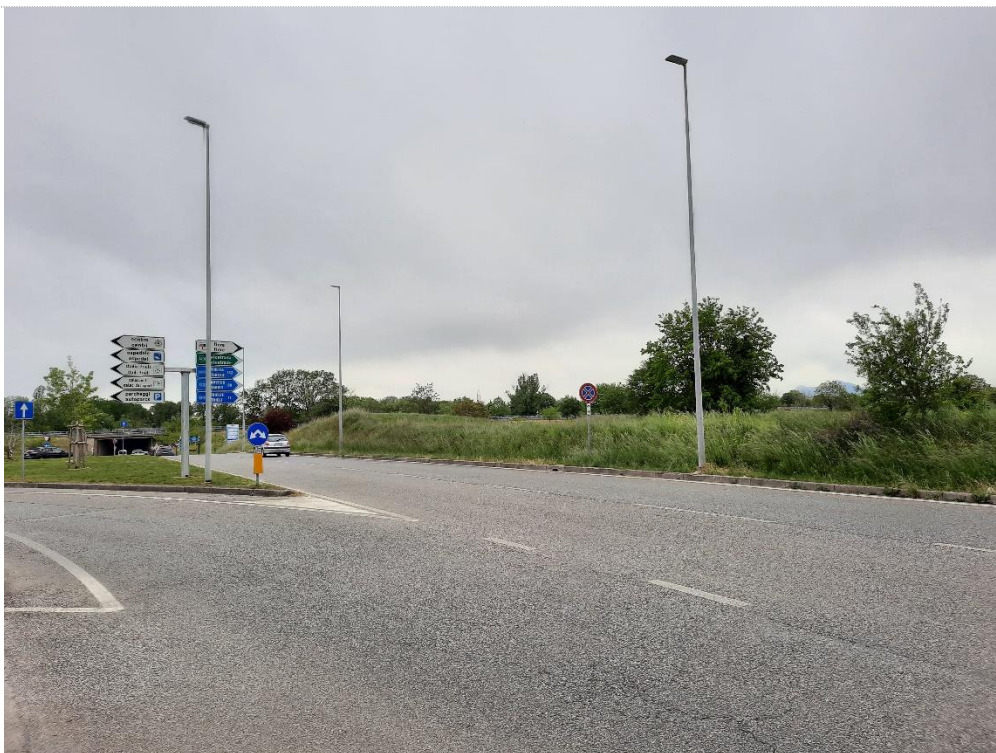
1. Veduta dai parcheggi dello stadio oltre via Giorgio Mainerio nel punto del sottopasso della A23. È ancora visibile parte del rilievo andato distrutto dai lavori delle infrastrutture (da sud-est verso nord-ovest).
