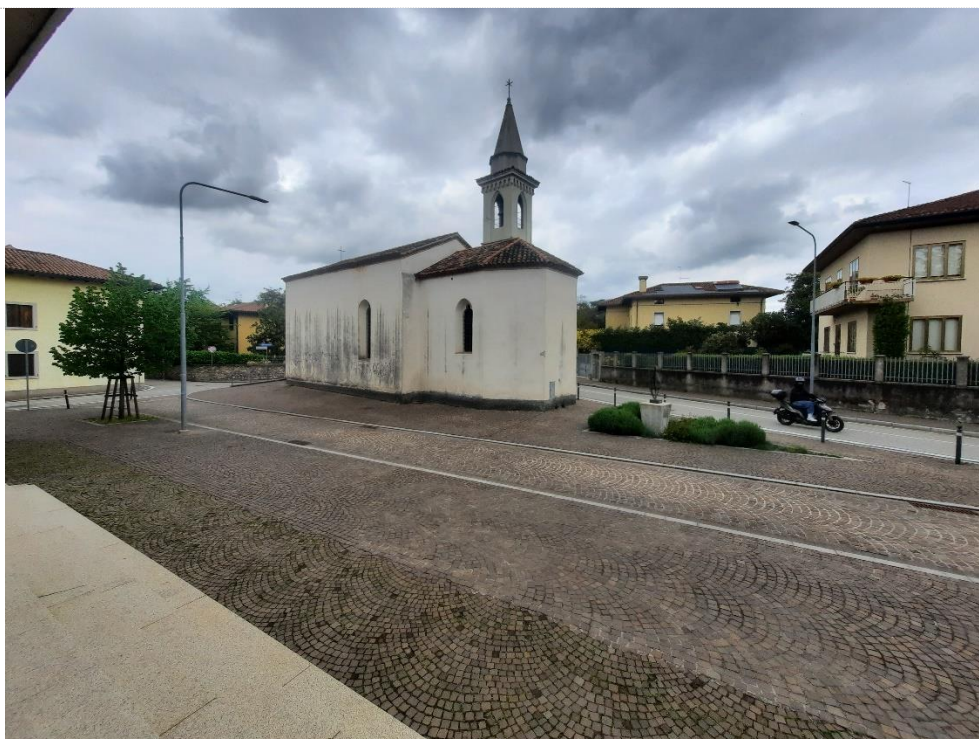
2. La chiesa si situa su sedime elevato rispetto alla viabilità (da sud-ovest verso nord-est).
