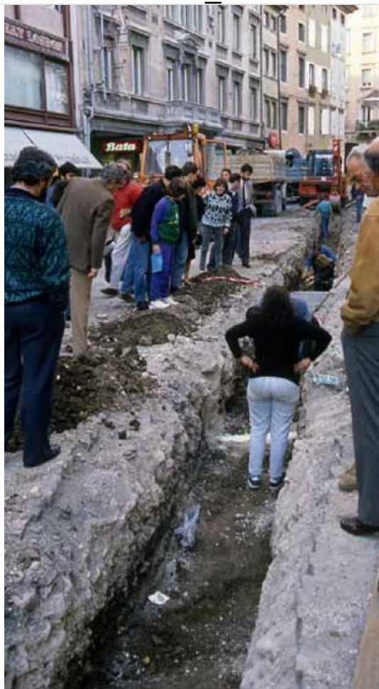
8. La trincea eseguita lungo via Mercatovecchio nel 1989 per la posa delle fibre ottiche: vennero intercettati livelli di età protostorica (da Visentini et alii 2021, p. 80, fig. 4).
