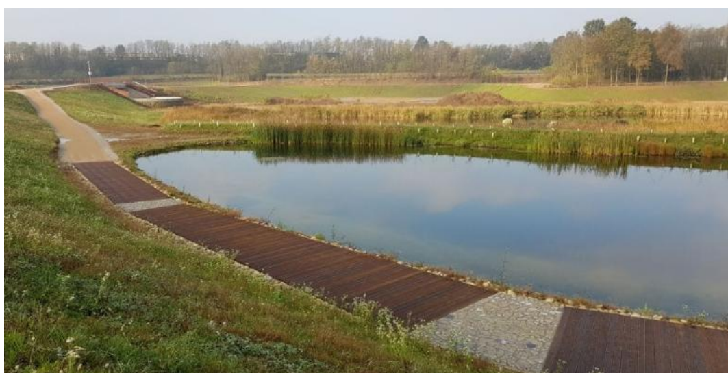
Figura 18: esempio di riqualificazione dell'area Prati del Ceppo lungo il torrente Lura in Lombardia.
