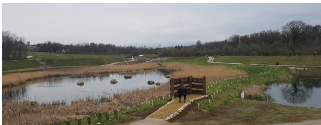
Figura 17: Il canale, visto da valle verso monte, dopo la realizzazione dell'intervento di riqualificazione fluviale: La banca in sinistra nella foto è stata abbassata in modo da creare una piccola golena allagabile, colonizzata in seguito dalla vegetazione e ulteriormente forestata mediante messa a dimora di piante sparse sia arboree che arbustive. La sponda è sorretta da una palificata e bordata da un parapetto in legno che permette una fruizione sicura del canale, ora con sponde più ripide (Foto: M. Monaci).
