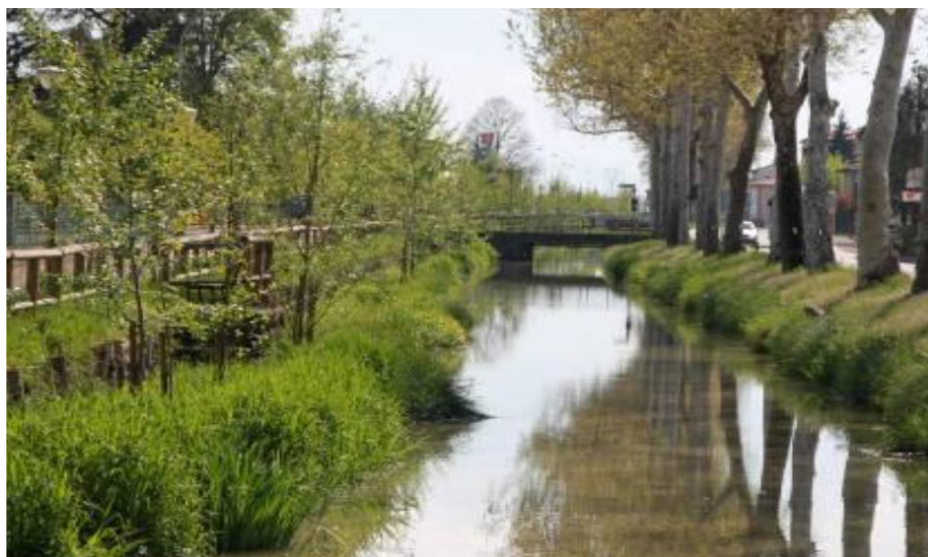
Figura 17: Il canale, visto da valle verso monte, dopo la realizzazione dell'intervento di riqualificazione fluviale: La banca in sinistra nella foto è stata abbassata in modo da creare una piccola golena allagabile, colonizzata in seguito dalla vegetazione e ulteriormente forestata mediante messa a dimora di piante sparse sia arboree che arbustive. La sponda è sorretta da una palificata e bordata da un parapetto in legno che permette una fruizione sicura del canale, ora con sponde più ripide (Foto: M. Monaci).
