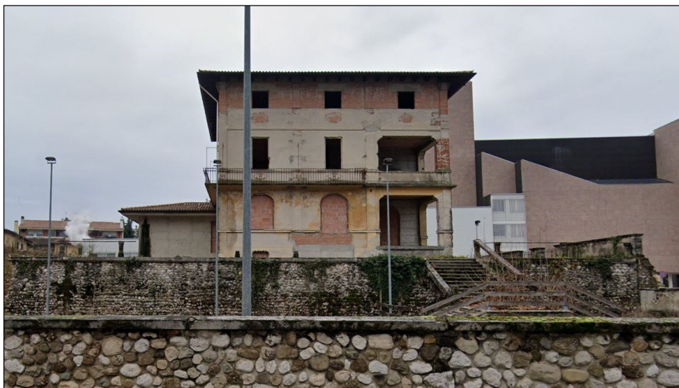
Figura 1: facciata est del fabbricato (si noti la scala di accesso che permetteva il superamento della quinta cinta muraria della città)
