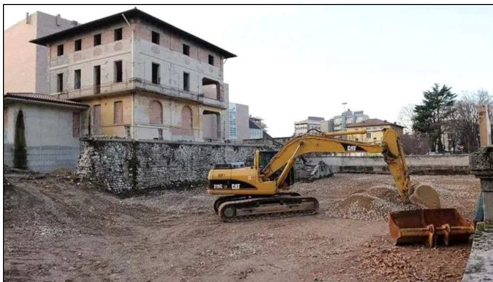
Figura 6: lavori attinenti alla realizzazione del parcheggio eseguiti nel 2013
