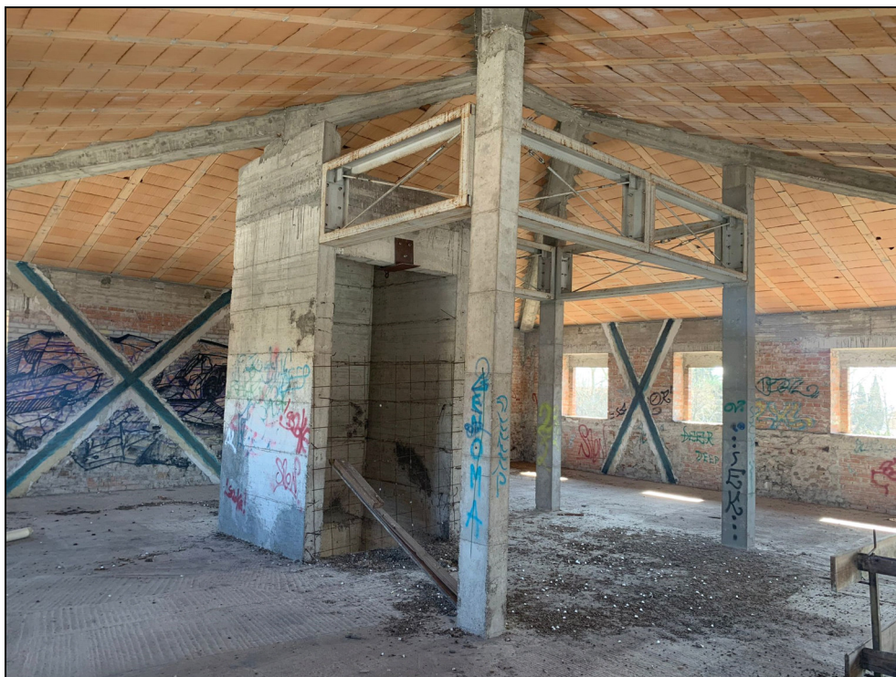
Figura 11: piano sottotetto rialzato (si noti l'applicazione dei controventi concentrici ad X per rendere solidali la vecchia muratura perimetrale con la sopraelevazione realizzata oltre la quota dei nuovi davanzali)
