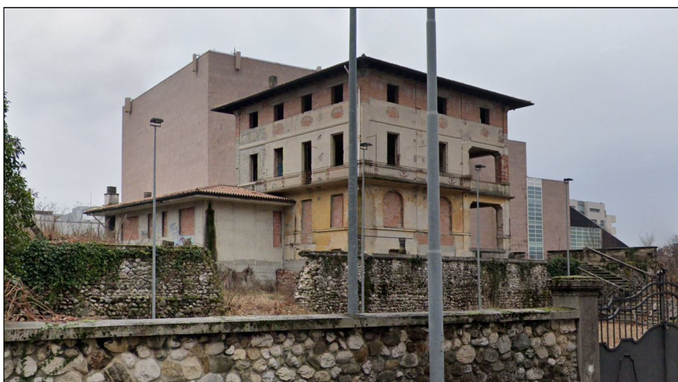
Figura 4: facciate sud ed est del fabbricato (si noti la superfetazione realizzata parzialmente sul fronte sud e la sopraelevazione dell'ultimo piano)
