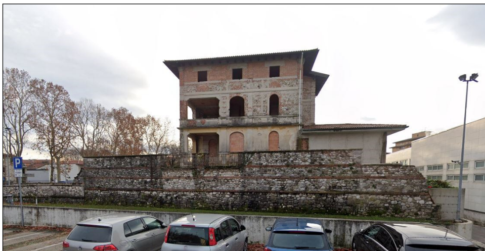
Figura 5: facciata nord del fabbricato (si noti la superfetazione realizzata sul fronte ovest e la sopraelevazione dell'ultimo piano)
