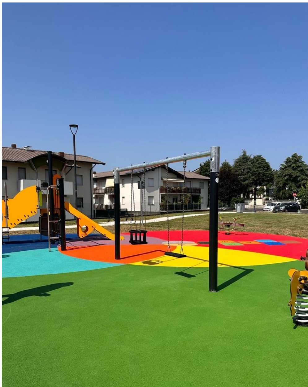
Figura 4.11 – L'area gioco realizzata in via Molin Nuovo e completata il 24 agosto 2023.
