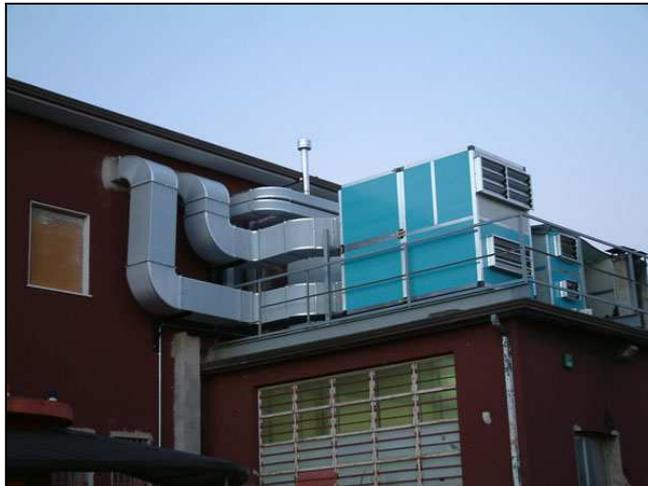
*Esempio di impianto di ventilazione spesso causa di disturbi acustici*
