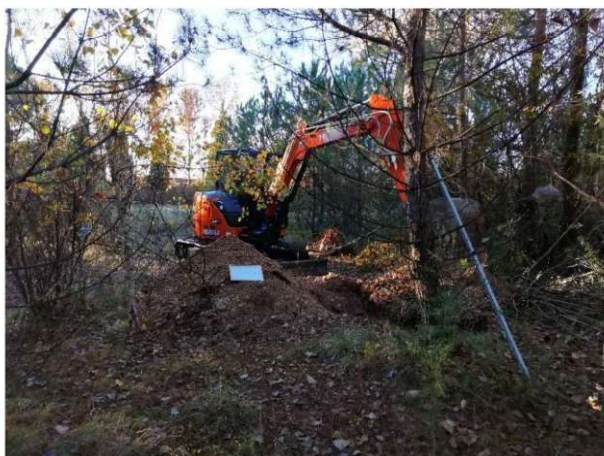
Figura 2.1 – Realizzazione dei sondaggi a trincea [foto: Multiproject]
