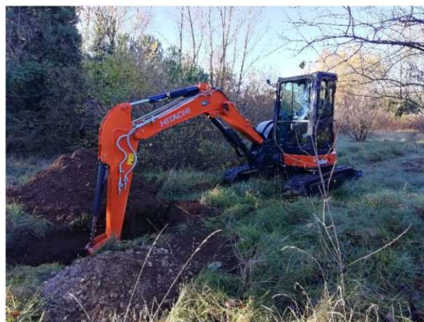
Figura 2.1 – Realizzazione dei sondaggi a trincea [foto: Multiproject]
